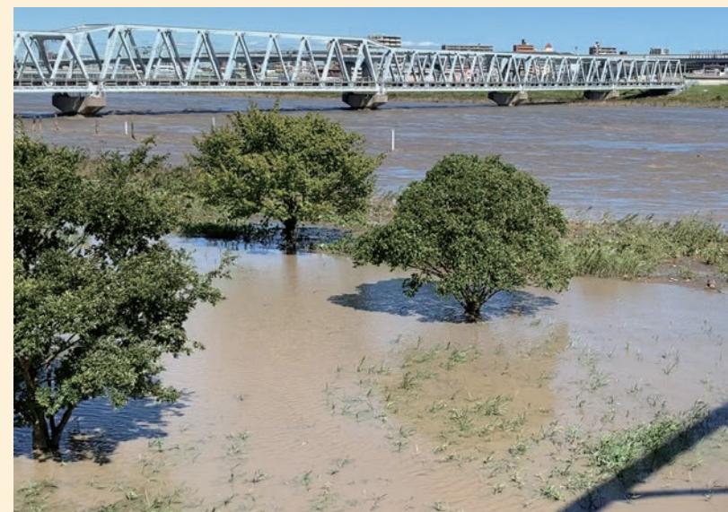
2019年の台風19号で増水した荒川の様子。氾濫危険水位まで約50センチに迫った
